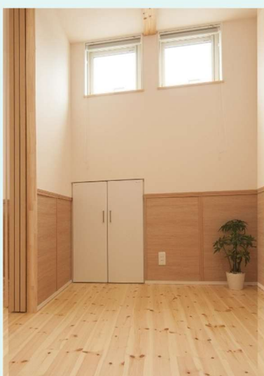
換気に威力を発揮する高窓
