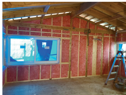
断熱材を隙間なく充填し、防湿シートを連続させて施工。
