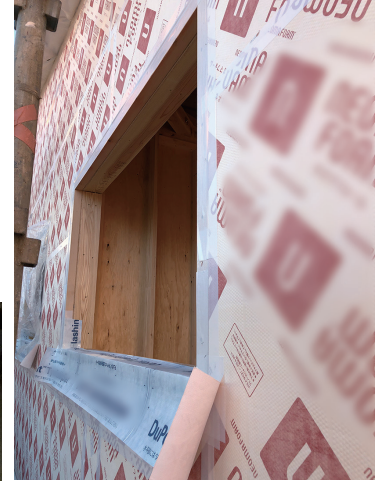
窓台に先張り防水シートを施工。
