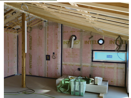
断熱材を隙間なく充填し、防湿シートを連続させて施工。
